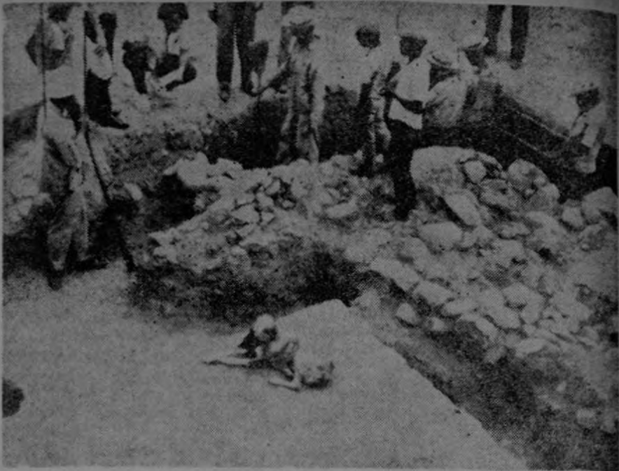
La foto fue tomada cuando se iniciaron los trabajos de excavación, en busca de los restos del ilustre ex Presidente Braulio Carrillo, en el poblado de sociedad, en El Salvador. El trabajo fue encargado por nuestro Embajador en Guatemala, Ing. Edwin Góngora.
